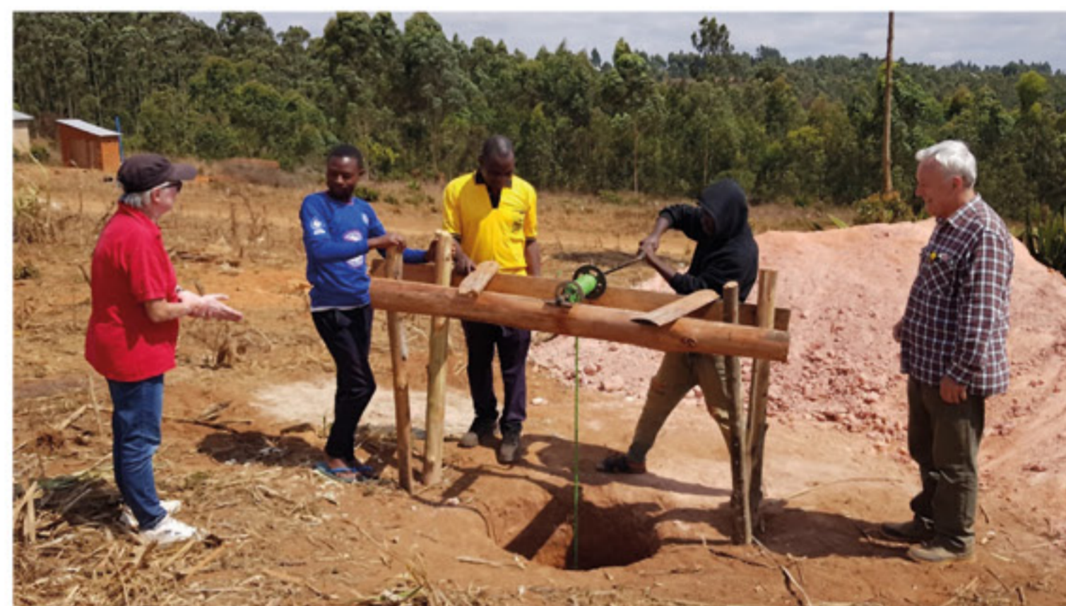
Il pozzo scavato
