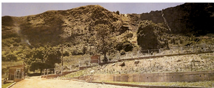
Immagine della Centrale di Lugarawa
