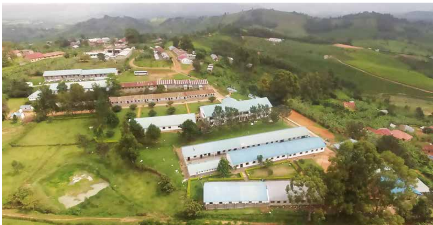
Veduta aerea dell'intero complesso del St. Mary's Vocational School
