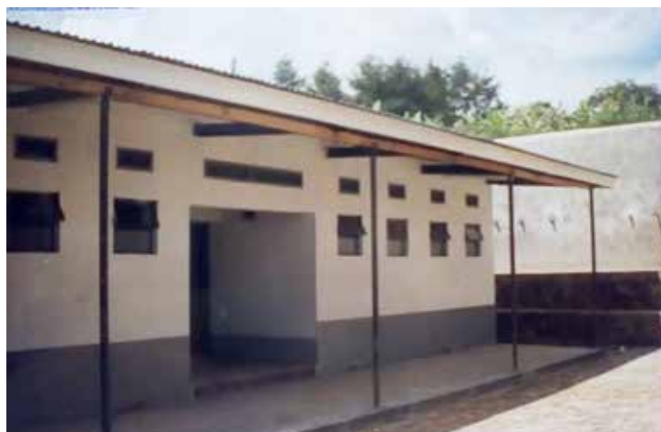
Il primo edificio realizzato nel 2003
