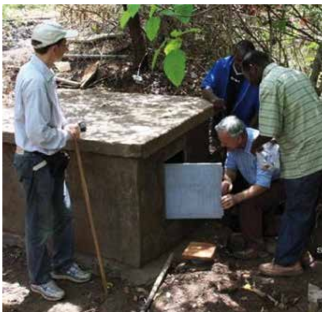
Sorgente principale acquedotto ospedale Lugarawa
