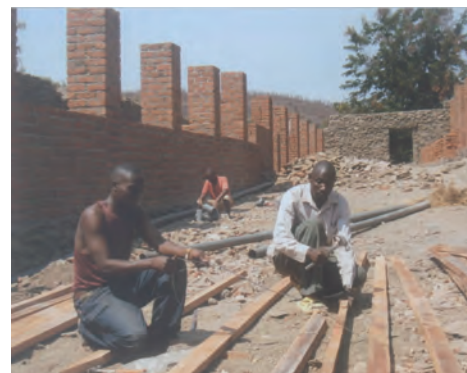
(Stalle in costruzione)
