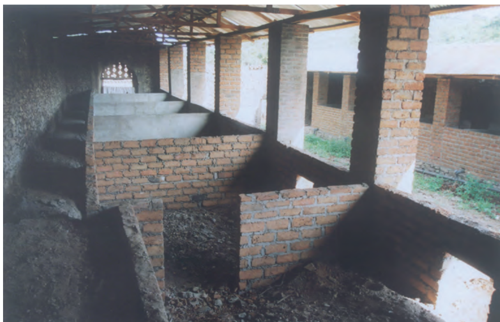
(Verso il termine dei lavori)
