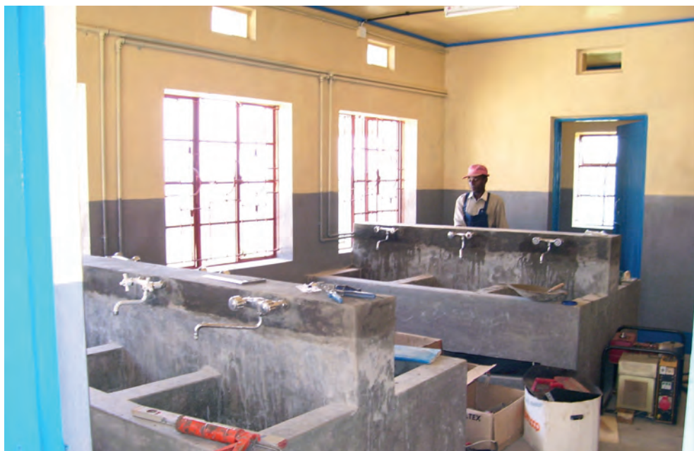
Lavanderia della sala operatoria in costruzione
